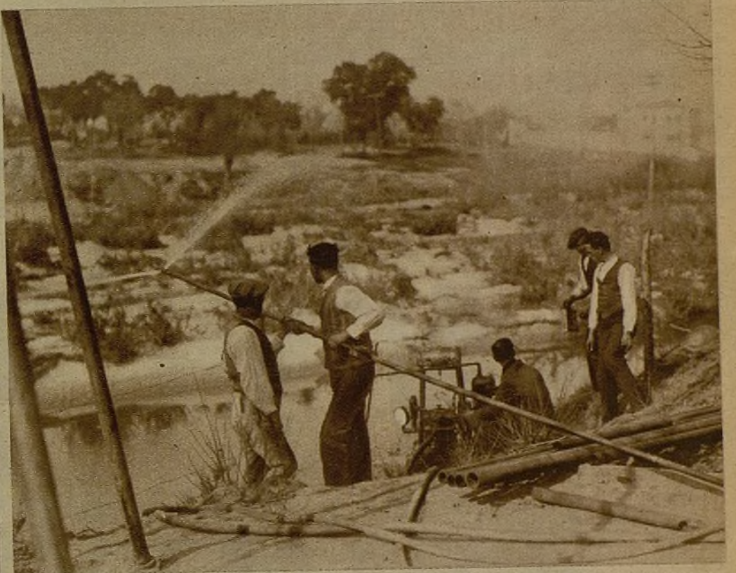
Bomba del desagüe de sondeo que en la actualidad se viene realizando para la construcción del puente sobre el Manzanares
