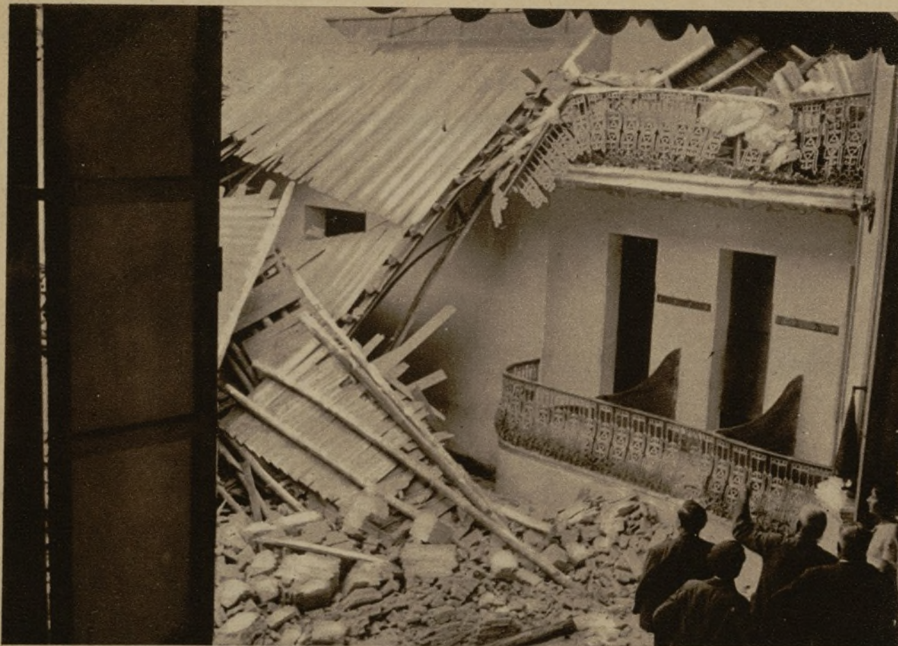
He aquí el estado en que quedó la sala del Teatro Principal de Alburquerque, al hundirse el techo momentos antes de la hora señalada para la función (Foto Persini)
