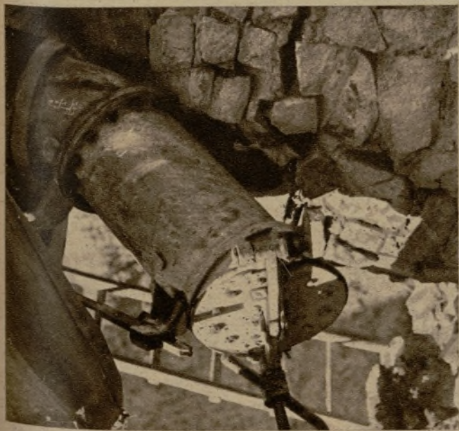
La manga alimentadora de aire, en la que se produjo la explosión. A consecuencia de ésta sobrevinieron derrumbamientos. En la foto se ve parte de un muro derribado y otro con profundas grietas (Fotos Gonsanhi)
