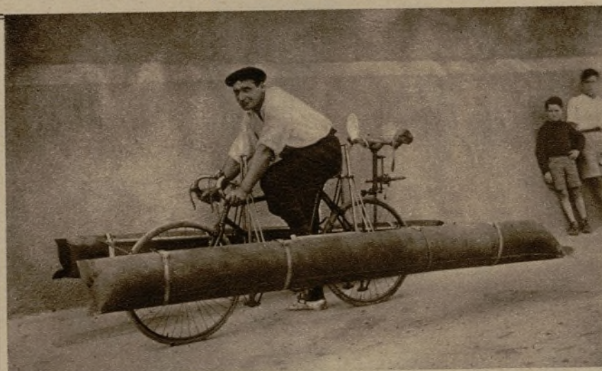
Un ingenioso vasco ha inventado estos dispositivos, que pueden aplicarse a bicicletas, motos y automóviles, para marchar indistintamente por tierra y por agua
