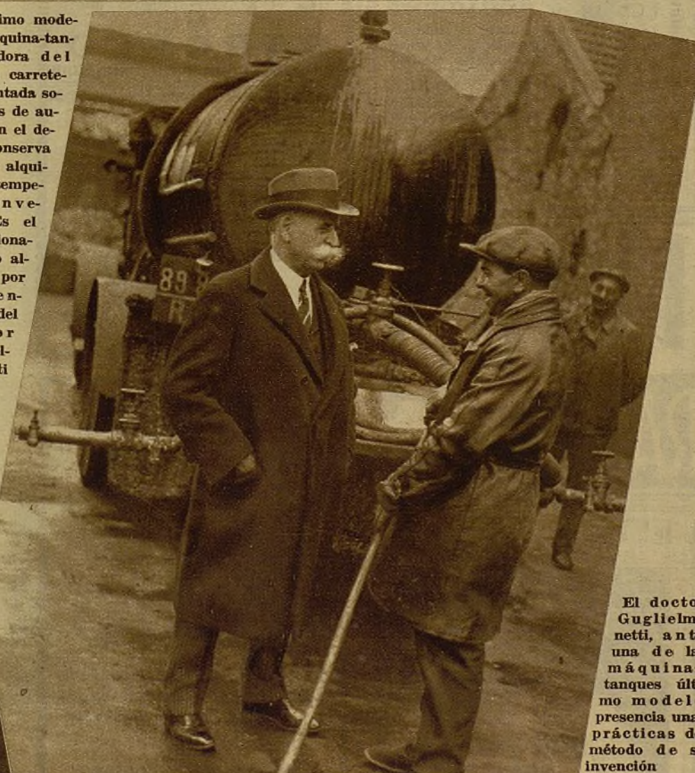
Esta máquina, en el procedimiento primitivo calentaba el alquitrán hasta elevar su temperatura al grado conveniente. La primera carretera a la que se aplicó el método del doctor Guglielminetti fué la de Niza a Mónaco
