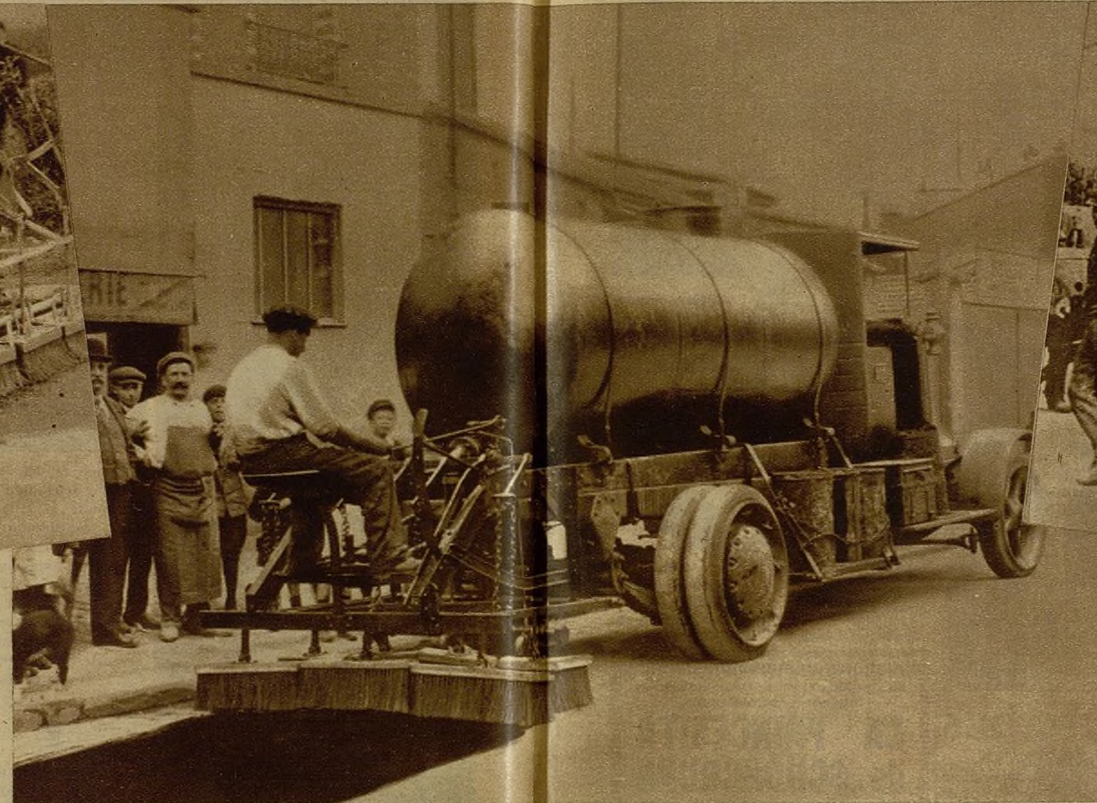
He aquí el último modelo de la máquina-tanque, distribuidora del betón en las carreteras. Está montada sobre un chasis de automóvil, y en el depósito se conserva la masa de alquitrán a la temperatura conveniente. Es el perfeccionamiento alcanzado por la invención del doctor Guglielminetti
