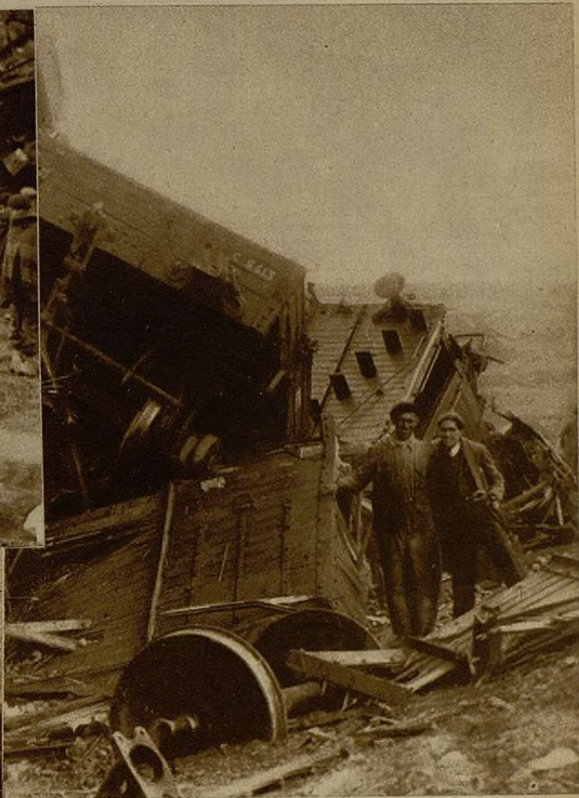
Al pasar un tren de mercancías por el puente de Lagartera, cerca de Avila, se rompió la mangueta de un vagón, y diez y nueve unidades, rompiendo la barandilla, cayeron desde una altura de veinte metros. Los restos de varios vagones, entre los cuales se cree que está el cadáver del mozo de tren Rafael Cuesta (Foto Contreras y Vilaseca)
