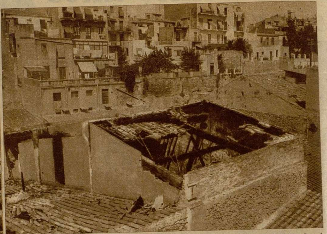
Aspecto del almacén de abonos de Tarragona después del fuego, que no dejó en pie más que los muros exteriores del edificio (Fotos Vallvé)
