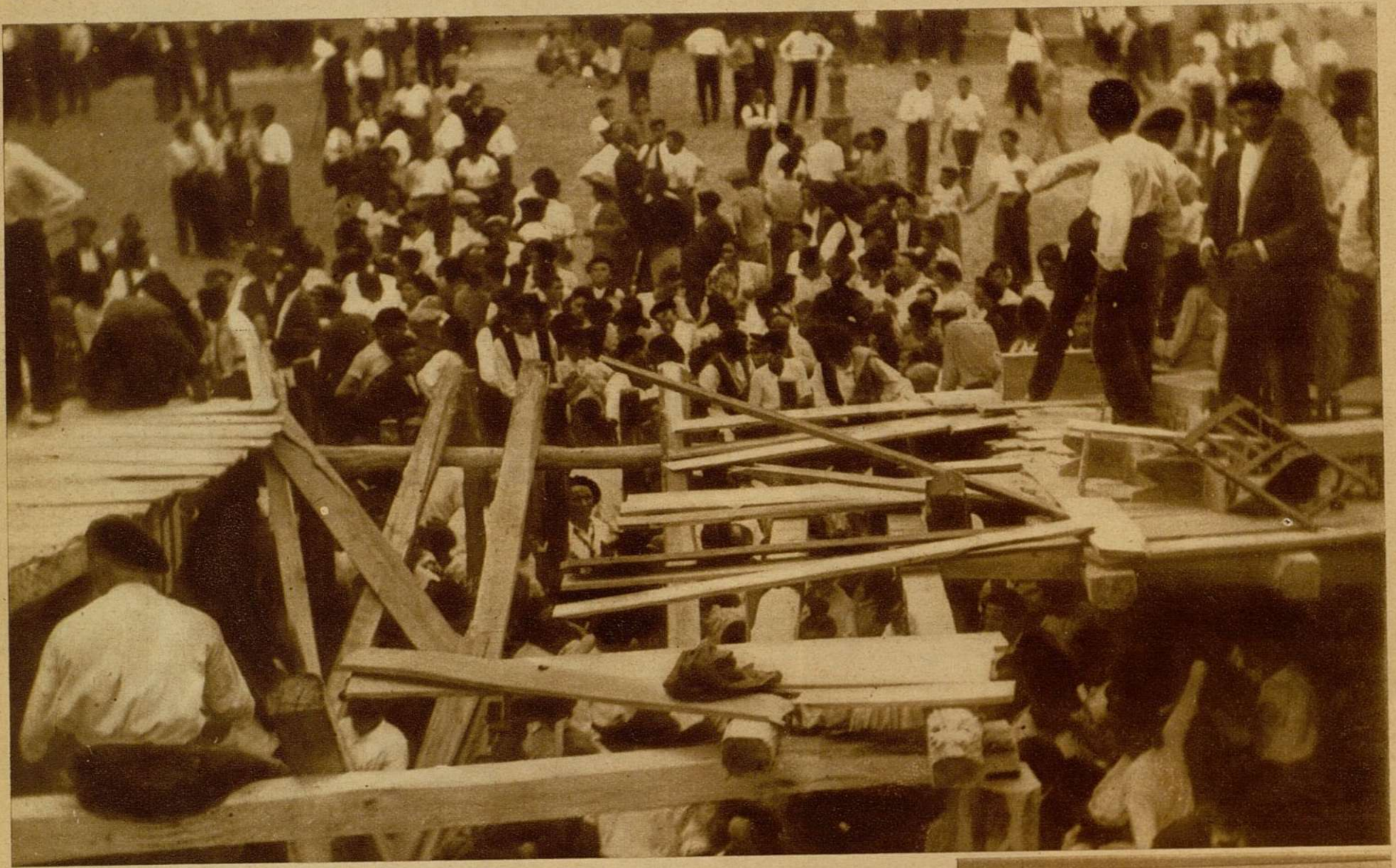
El tendido de la plaza de toros de Cuéllar que se hundió durante la celebración de la novillada de la feria del pueblo. El andamiaje cedió al peso de las numerosas personas que ocupaban aquel lugar, y resultaron numerosos espectadores heridos (Foto García)
