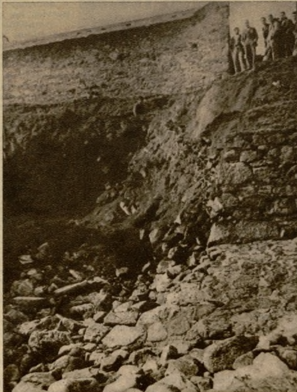
También en La Coruña ha producido destrozos el temporal, derribando el mar un muro próximo a la estación del ferrocarril y dejando al descubierto los rieles (Foto Cancelo)
