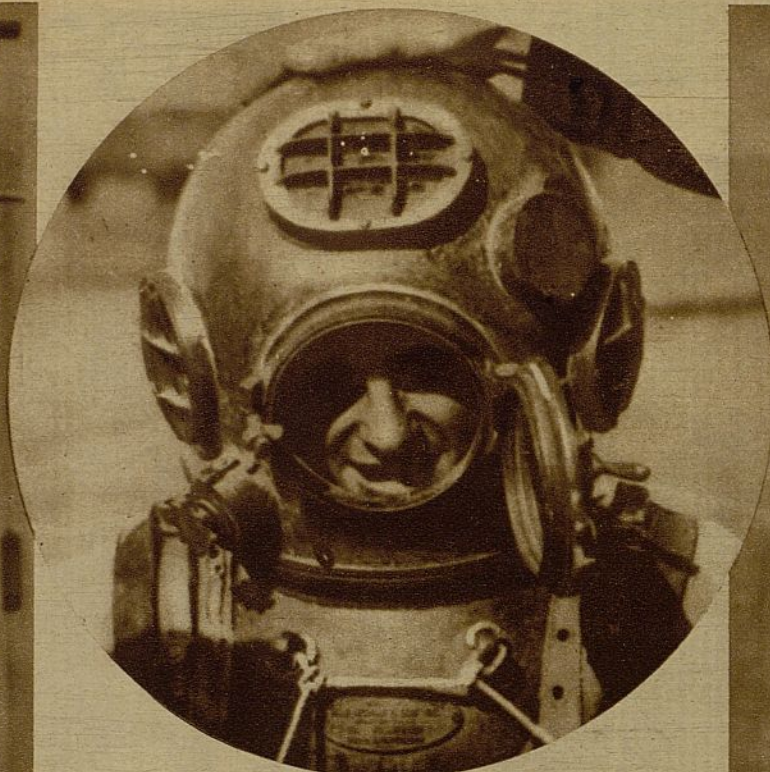
La escafandra del buzo moderno transforma al hombre en un sér de apariencia extraña y monstruosa. Al fin y al cabo, se trata nada menos que de trasladarse a otro elemento, en el que las condiciones de vida reclaman la adopción de una indumentaria que proteja al delicado organismo humano de las enormes presiones que es necesario soportar en las profundidades del mar (Foto Orrios)
