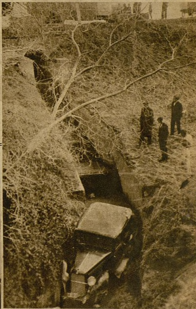
A consecuencia de las pertinaces lluvias, se produjo un desprendimiento de tierras en la línea del ferrocarril entre Montejurado y San Clodio (Coruña), descarrilando un tren mixto, varios de cuyos vagones, por fortuna de mercancías, rodaron por un terraplén. Una hora después había de pasar por el lugar del accidente el tren expreso
