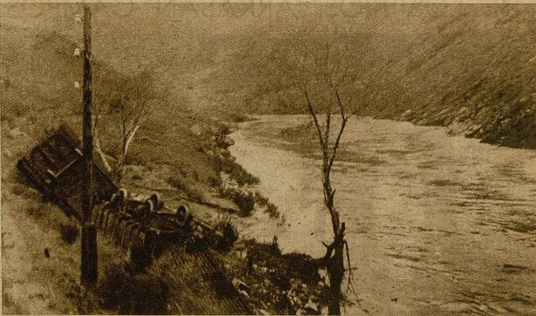
A consecuencia de las pertinaces lluvias, se produjo un desprendimiento de tierras en la línea del ferrocarril entre Montejurado y San Clodio (Coruña), descarrilando un tren mixto, varios de cuyos vagones, por fortuna de mercancías, rodaron por un terraplén. Una hora después había de pasar por el lugar del accidente el tren expreso
