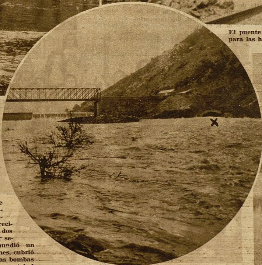
Lugar en que se desplomó un talud de 3.000 metros cúbicos, incomunicando la carretera de Navahermosa-Logrosán
