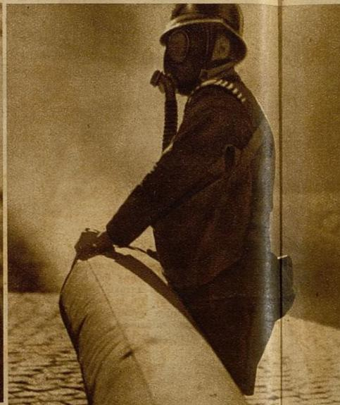
Una bomba aspiradora extrae el humo del lugar enrarecido y permite la renovación inmediata del aire. He aquí el tubo que da salida a la calle al humo y a los gases
