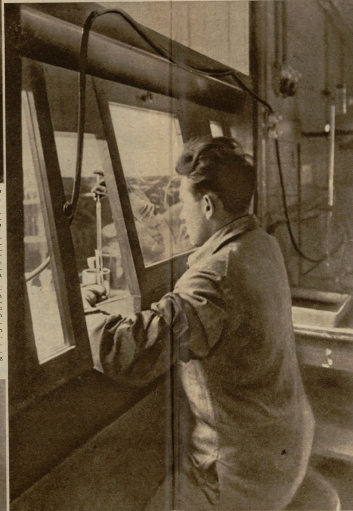
Con grandes precauciones, provisto de guantes de goma y protegido por placas metálicas y cristales especiales, este operario procede a la disolución en agua de las sales de radio, para su dosificación terapéutica. (Foto Fundis)
