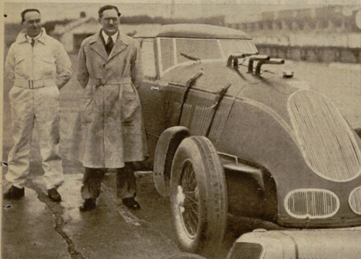
Keyston, "el cazador de records", ha establecido en Monthlery una serie de "records" de significación para el futuro... puesto que ha sido logrado en un coche con motor de aceite (Diesel): un kilómetro, en 19 s. 38/100; una milla, en 34 s. 19/100; cinco kilómetros, en 1 m. 37 s. 9/100; cinco millas, en 2 m. 36 s. 54/100 (velocidad media: 185 kilómetros 058 por hora, para la distancia mayor). Son los primeros "records" oficialmente registrados en el mundo para motores de aceite pesado.
