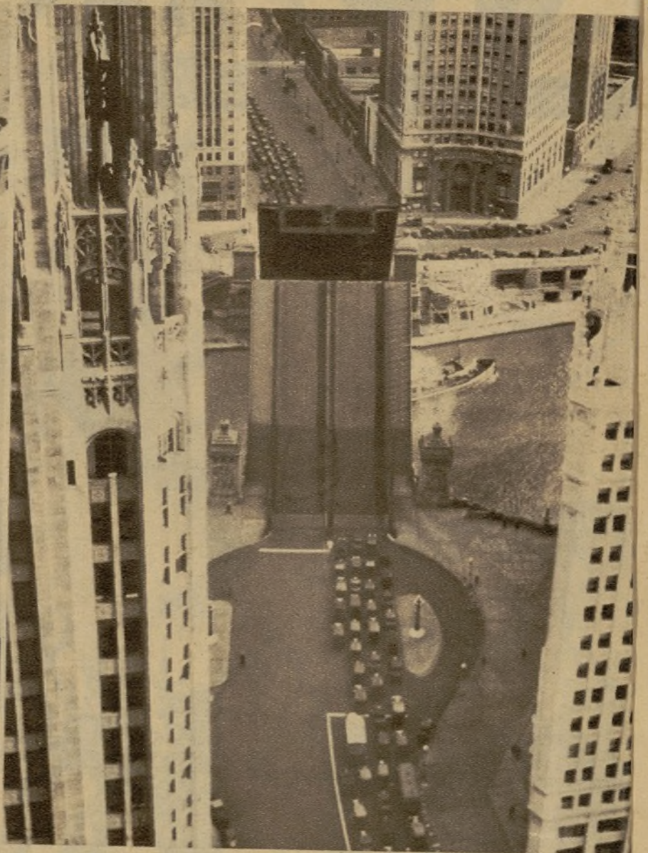
El mismo puente, cuando se despliega en sus dos mitades para dar paso a los buques que navegan por el río (Fotos Serra, Contreras y Vilaseca y Díaz Casariego)
