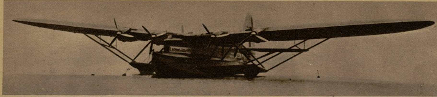
El hidroavión "Lieutenant de Vaisseau Paris", actualmente en período de ensayo, quiere ser el mayor hidroavión del mundo, con sus 37 toneladas y sus 6.000 caballos. Será destinado a la línea aérea Francia-América del Sur
