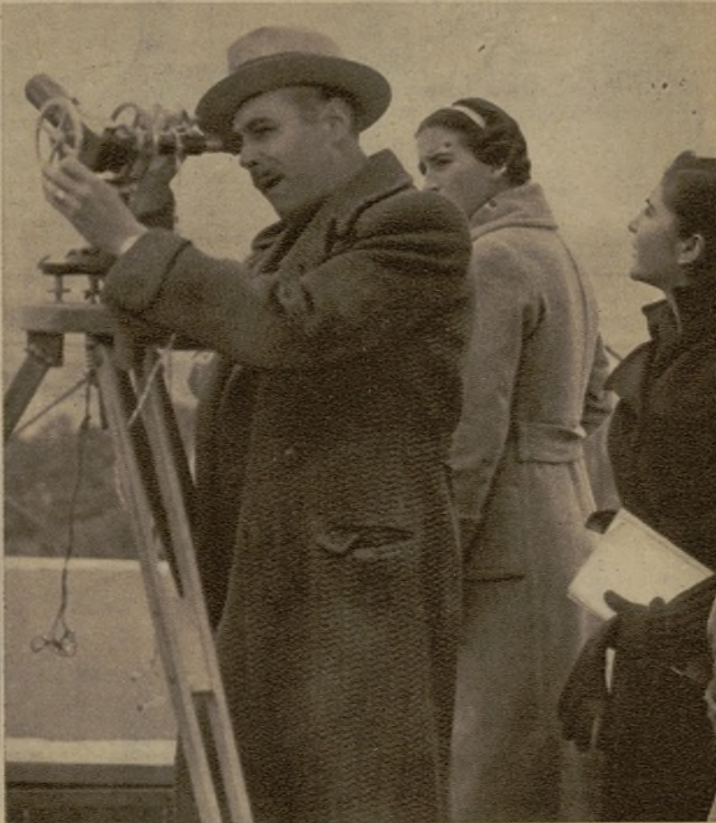
Uno de los técnicos del Observatorio sigue, por medio del teodolito, las evoluciones del globo sonda
