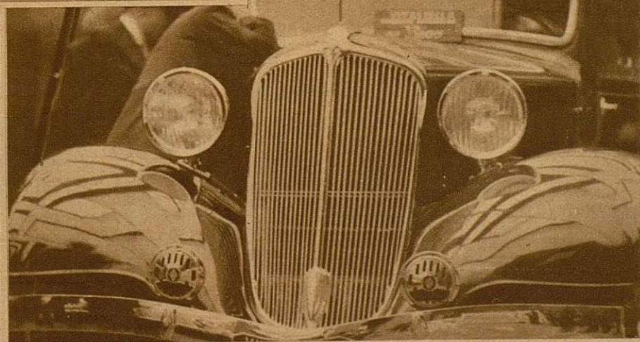
"Aletas que envuelven las ruedas y se prolongan hasta el parachoques, suprimiendo los "pasillos de aire", radiadores tendidos, en forma de V..."
