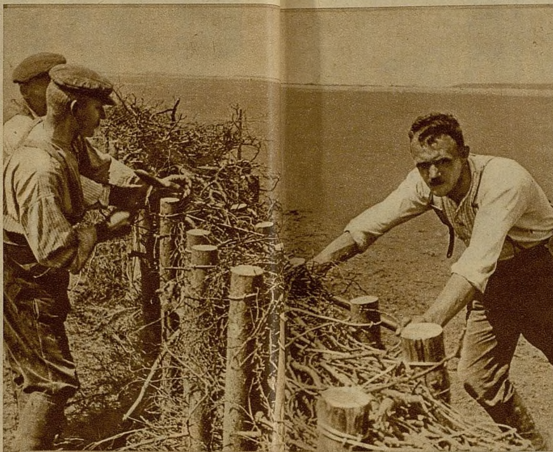
Para evitar que el flujo y reflujo de la marea ame nuevamente la tierra conquistada al mar, estos obreros del "Servicio de trabajo voluntario" erigen sólidas alambradas con estacas y ramaje (Foto Rawicz)
