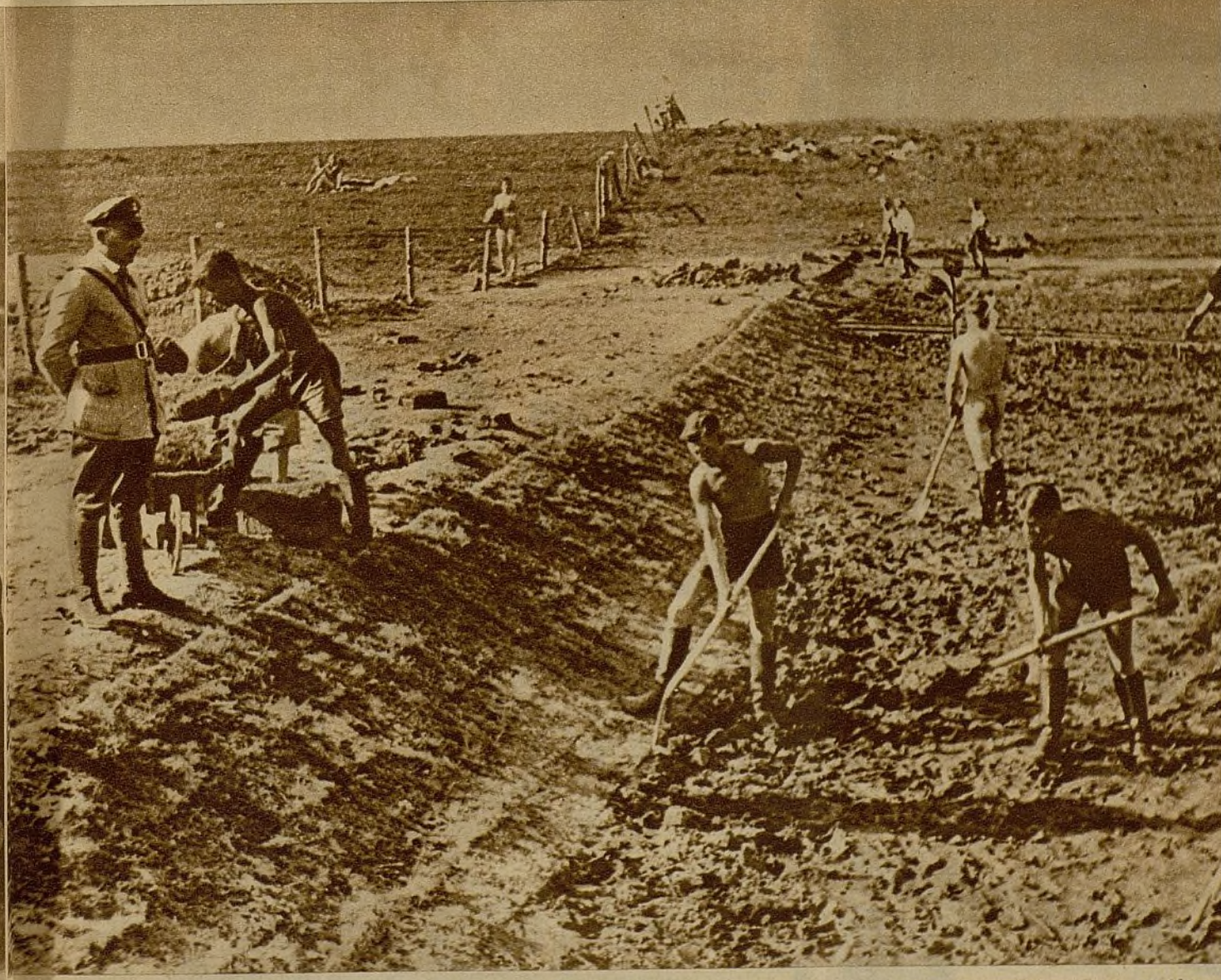
A costa de un trabajo lento y rudísimo, estos obreros del "Servicio de trabajo voluntario" construyen terraplenes con el légamo, las algas y los residuos del fondo del mar, hasta levantar convenientemente el nivel de la orilla (Fotos Rawicz)
