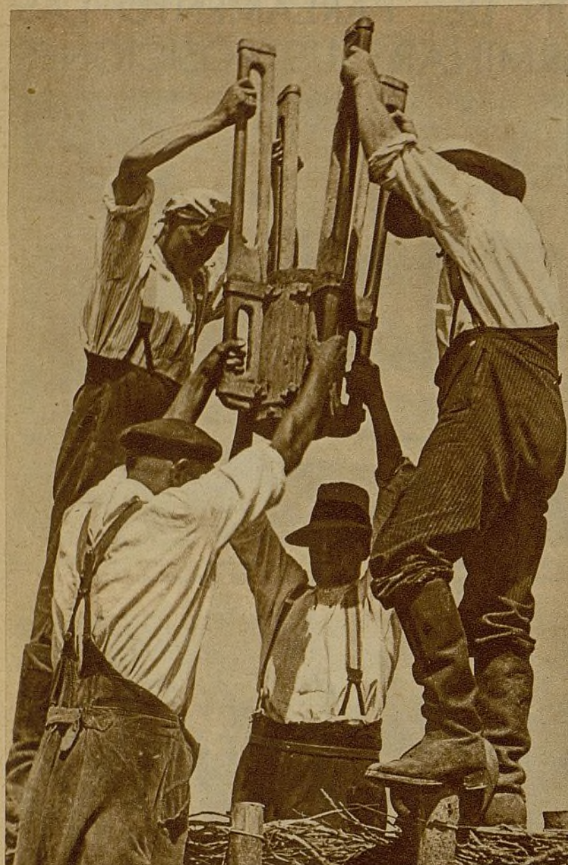
Este método colectivo para clavar estacas en la tierra, fangosa y movediza, de la orilla del mar, durante la resaca, es antiquísimo y de probada eficacia (Foto Rawicz)
