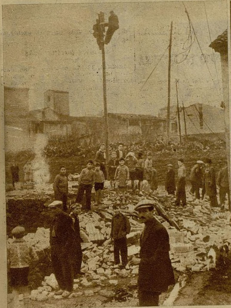
En Manresa se han cometido varios atentados en postes y transformadores de energía eléctrica. He aquí el lugar donde se hallaba asentada una torreta, y de la que no han quedado más que escombros, a consecuencia de la explosión de una bomba
