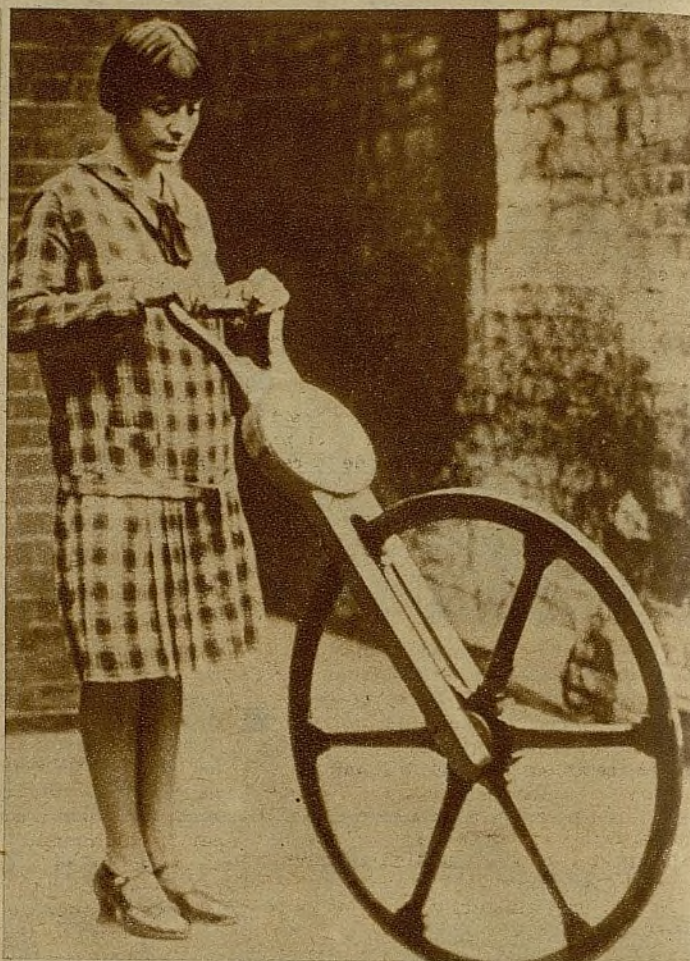
EL ANTECEDENTE DEL TAXIMETRO. —En el Museo Postal de Londres se conserva este aparato, del tiempo de Ana Bolena (1507-1536), que se considera como el antecedente del "taxi". Se compone de una rueda en combinación con un cuadrante, y servía para medir la longitud de las distancias por carretera para establecer las tarifas de alquiler de los caballos de las postas
