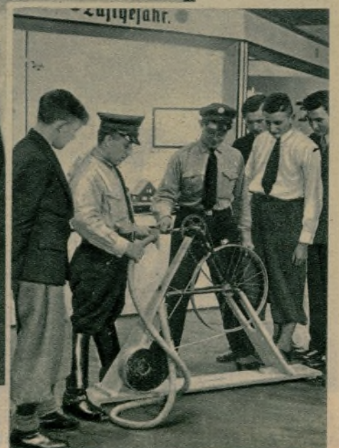
Los alemanes también se preocupan del gas. Aquí están enseñando a unos muchachos a improvisar un aparato para limpiar el aire con el sencillo mecanismo de una bicicleta
