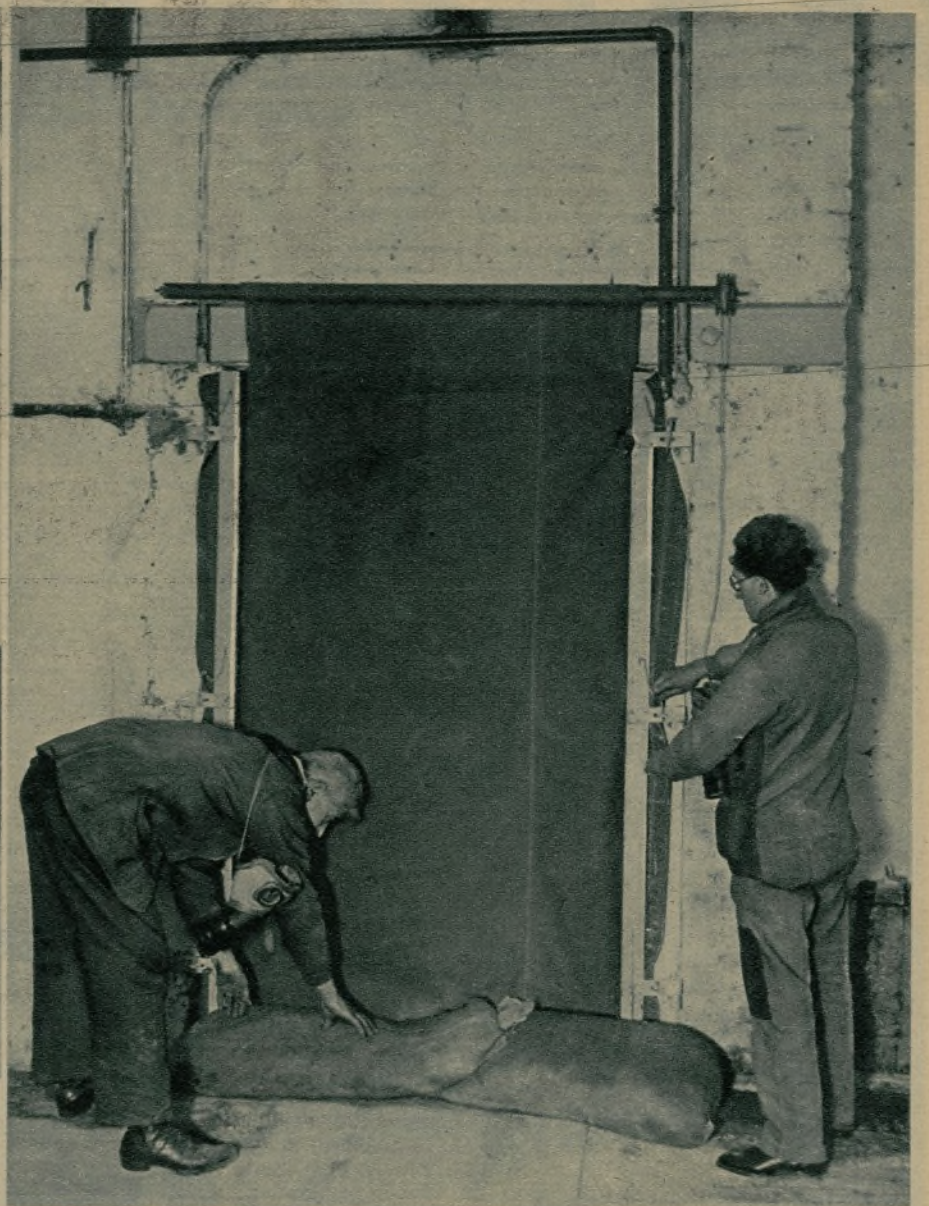
En estos abrigos contra los gases, contruidos por los franceses, en los que pueden refugiarse muchos centenares de personas, el aire puro captado en las alturas y lanzado con una fuerte presión impedirá la entrada del aire viciado
