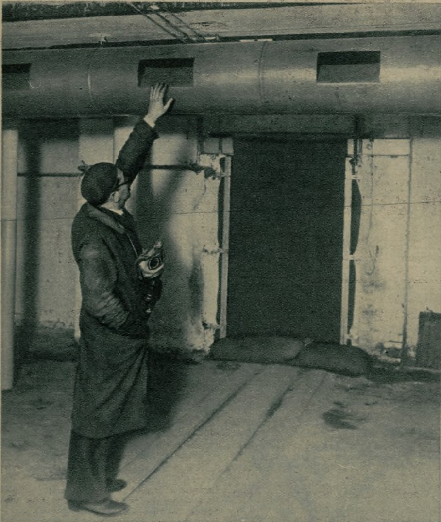
Contra los gases se ensayan constantemente procedimientos de defensa. Los franceses han construido en Roubaix este abrigo, en el que las personas refugiadas en él podrán respirar aire puro, captado de la atmósfera por una chimenea de veinticinco metros. Sabido es que los gases tóxicos se pegan a la tierra y dejan la atmósfera limpia a una cierta altura
