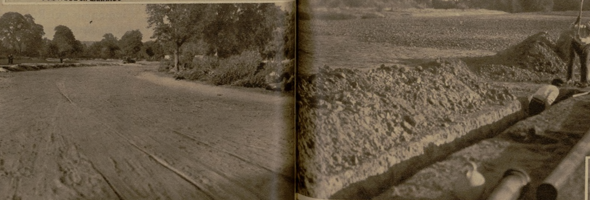
Los obreros trabajan activamente en la instalación de las conducciones de riego, que permitirán tener verde, cubierta de un tapiz de hierba, la pista del Hipódromo (Foto Almazán)
