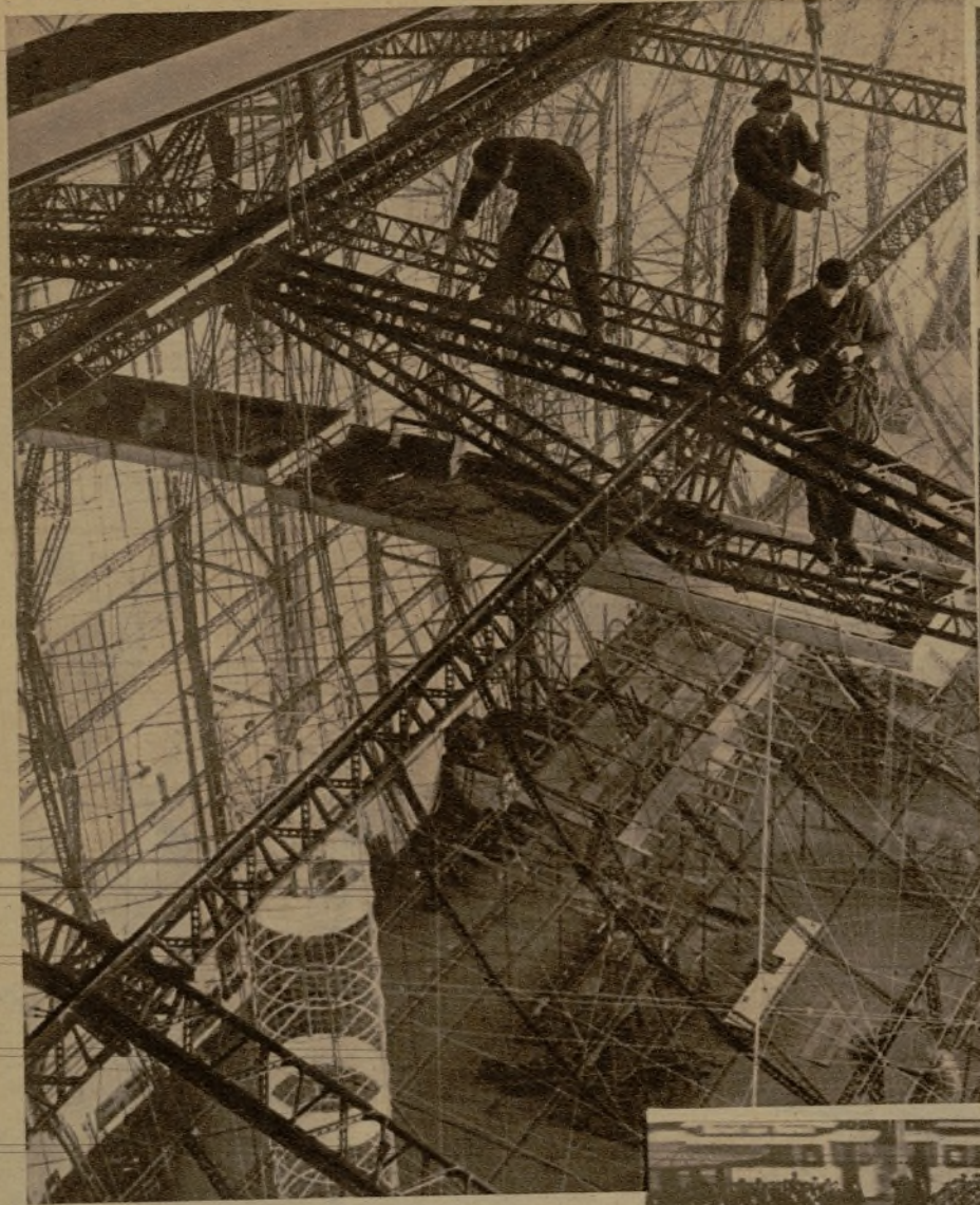
He aquí la última fotografía obtenida del nuevo buque aéreo, a cuya construcción se dedican con toda actividad en los talleres Zeppelin, de Friedrichshafen. La armadura metálica está casi terminada
