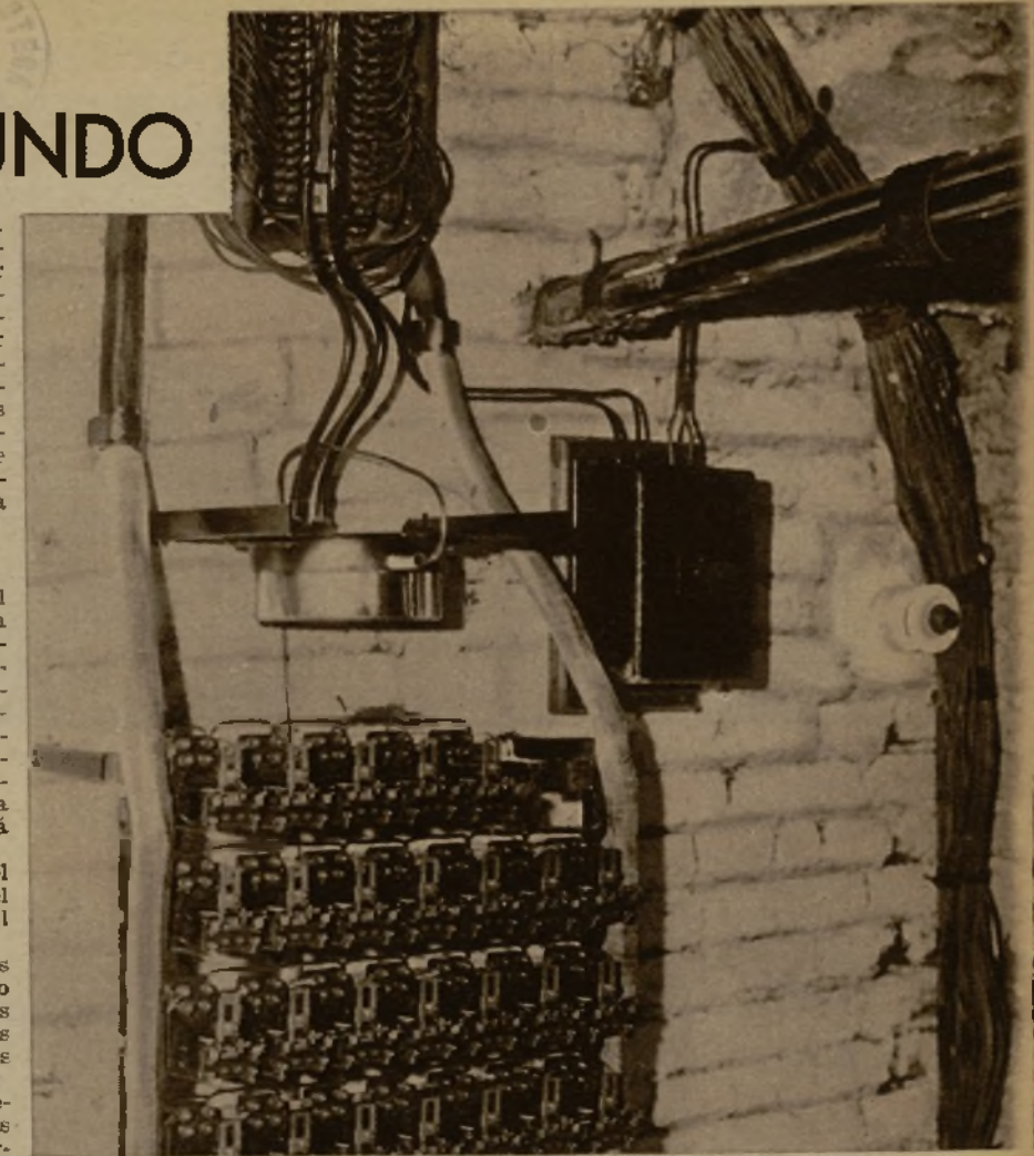
Este conjunto de complicados aparatos sirve para que la transmisión de la temperatura desde un termómetro que la marca en su origen se efectúe eléctricamente al termómetro monumental
