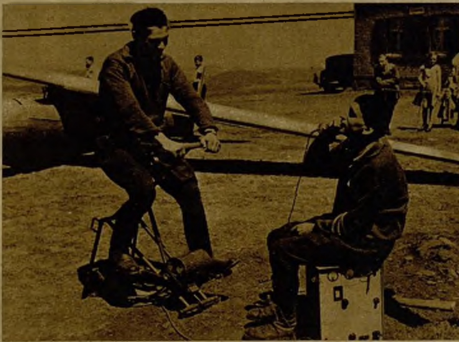
En los vuelos a vela, las órdenes se transmiten con emisoras portátiles, produciendo la corriente eléctrica generadores de pedales
