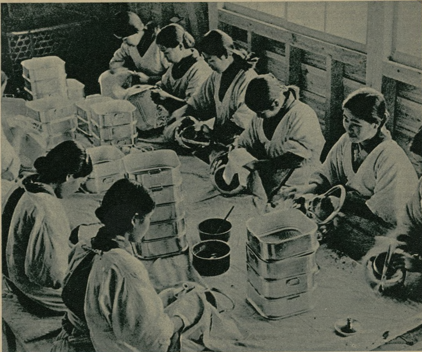
Después de sometidos a la presión del vapor, unas operarias lavan los objetos de almité con agua y jabón
