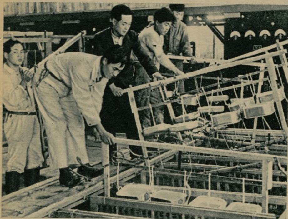
El aluminio, una vez galvanizado en un baño oxigenado y salino, se convierte en un nuevo producto: el almité, inatacable por los ácidos (Foto Erck)
