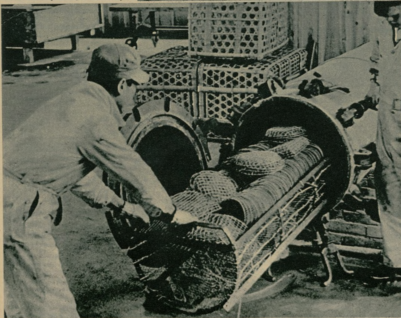
Una vez realizada la galvanización, los productos de almité son sometidos a una presión de cien libras y a una temperatura de 150 grados Celsius (Fotos Erck)
