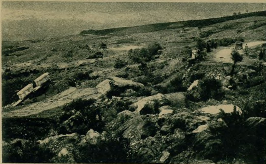
La carretera Tetuán-Melilla, por efecto de los corrimientos de tierras causados por las persistentes lluvias, ha quedado cortada en muchos trozos y en el estado que se ve en la fotografía (Foto Moderna)
