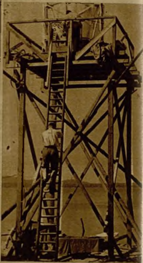
Instalación de un equipo de ondas centimétricas a orillas de un lago, para ensayos en la dirección de barcos
