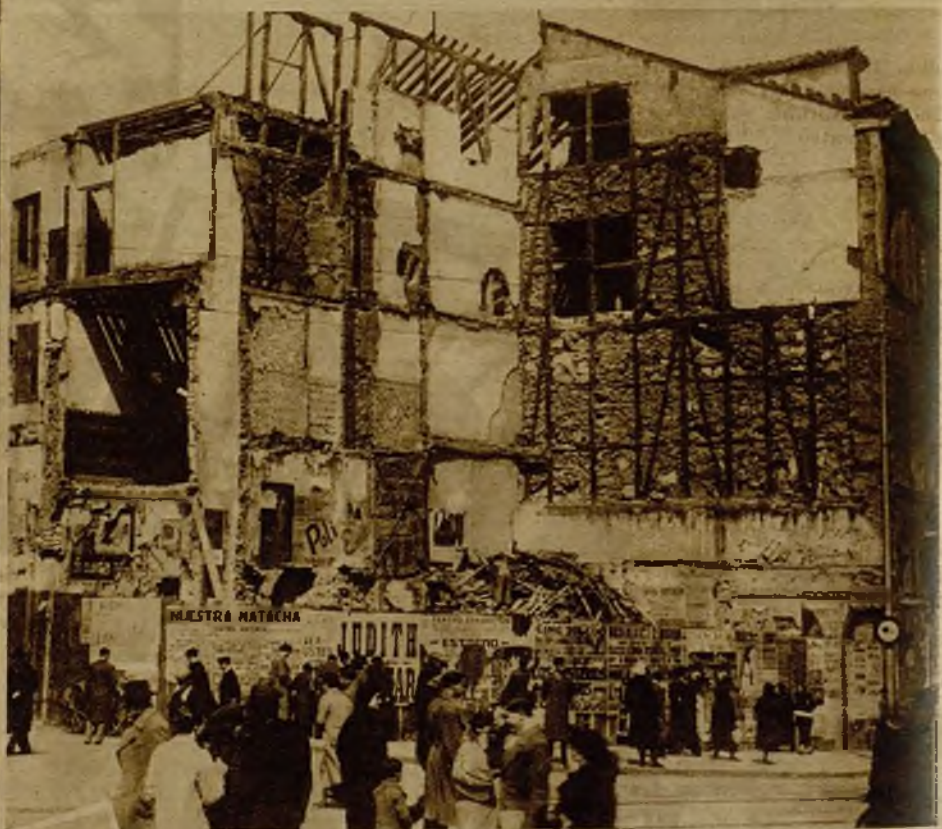
Vista exterior del derribo del teatro Romea, cuya demolición se efectúa para la construcción de la futura plaza de Jacinto Benavente
