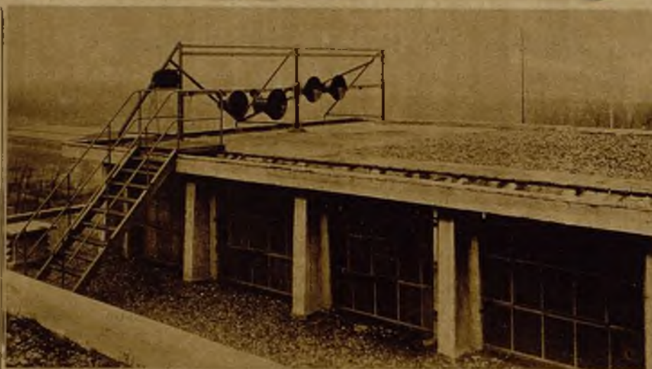
Stand de demostración para pruebas de altavoces instalado en una terraza
