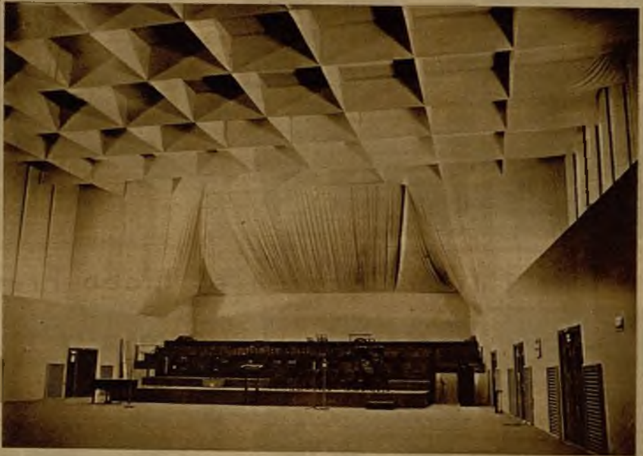
El nuevo salón de emisiones de la Radio de Berlín. Las paredes y el techo están cubiertos de tela, para evitar las vibraciones
