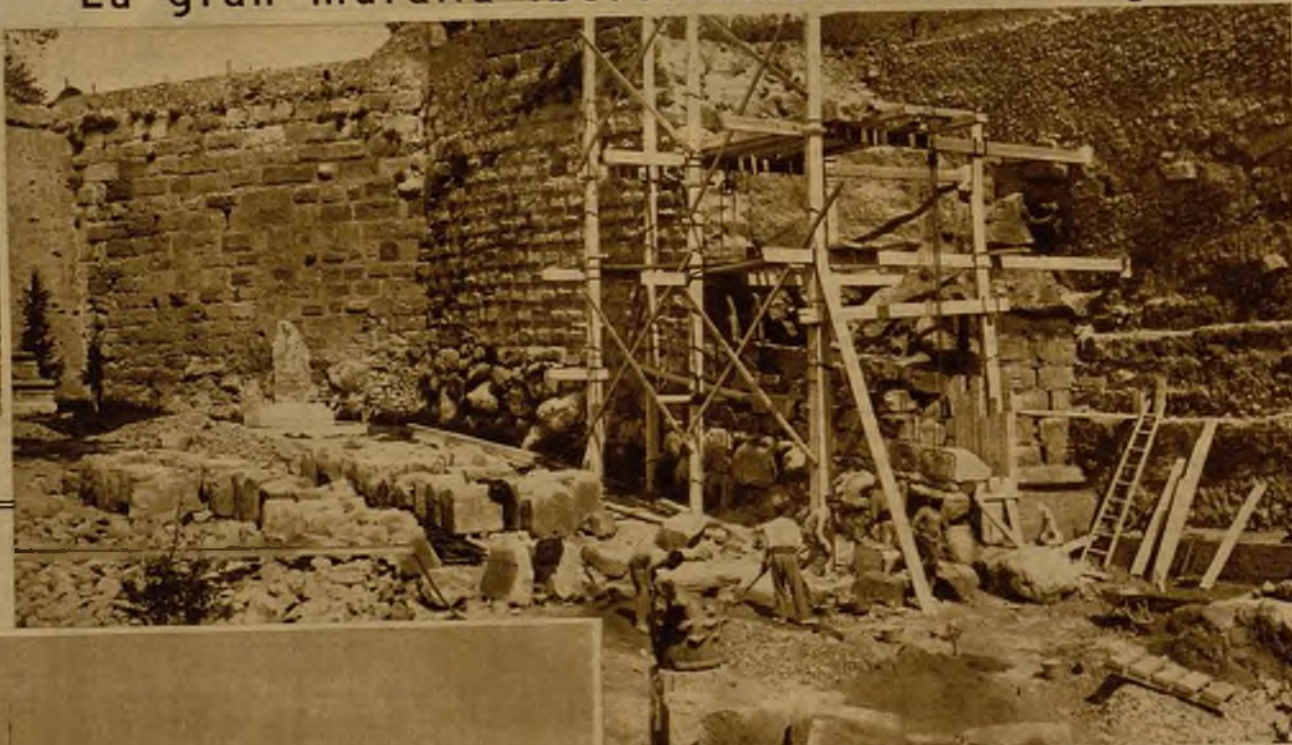
Estado en que se encuentran las obras, a las que se imprime gran actividad, de la consolidación de la gran muralla iberorromana, en Tarragona, que se derrumbó a consecuencia de las lluvias
