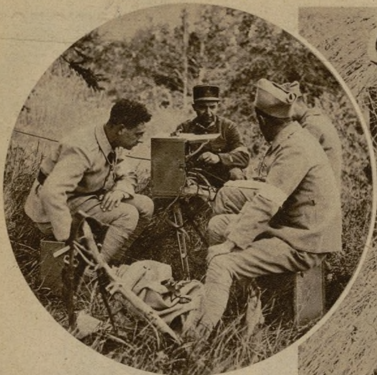
Uno de los telégrafos de campaña recibiendo las comunicaciones del Alto mando, que transmite a los destacamentos para encauzar la marcha de las maniobras y corregir los movimientos tácticos
