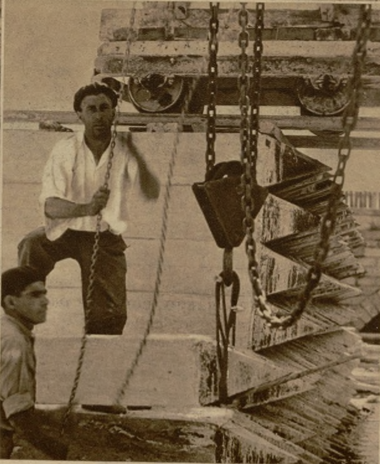
Los obreros desmontando los sillares de piedra del puente de Segovia, para efectuar el ensanche (Fotos Contreras y Vilaseca y Yusti)
