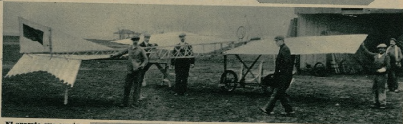
El aparato que construyó José González Camó con la ayuda de un carpintero de armar, de Getafe. La hélice estaba cortada de un mostrador de nogal de una taberna de Embajadores...
