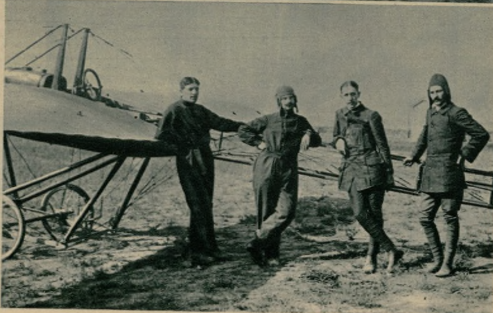
El aparato que construyó José González Camó con la ayuda de un carpintero de armar, de Getafe. La hélice estaba cortada de un mostrador de nogal de una taberna de Embajadores...
