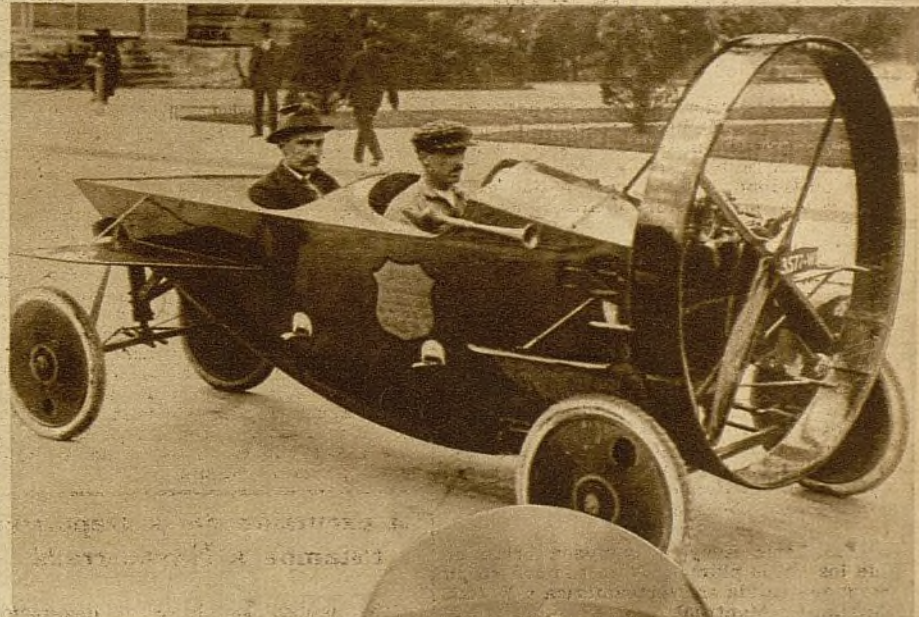
El coche de dos ruedas de bizarra forma, invento de un austriaco en 1914. Las ruedecitas centrales servían sólo para "despegar". Una vez puesto en marcha el coche, desaparecían automáticamente
