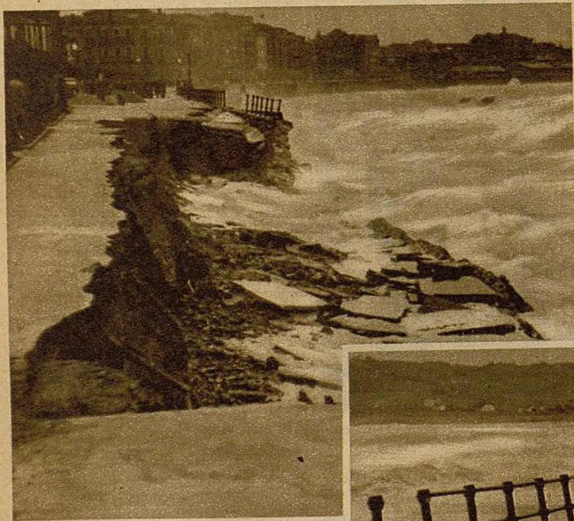
Restos del muro de la playa de San Lorenzo, que socavaron y destrozaron las aguas (Fotos Suárez)
