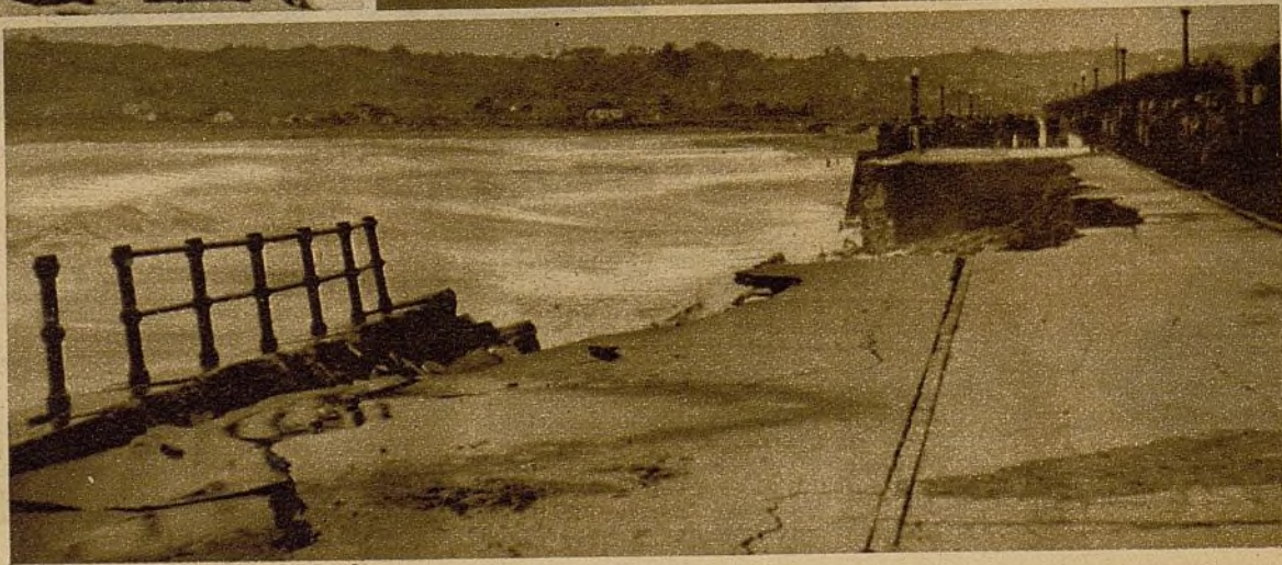
Restos del muro de la playa de San Lorenzo, que socavaron y destrozaron las aguas (Fotos Suárez)
