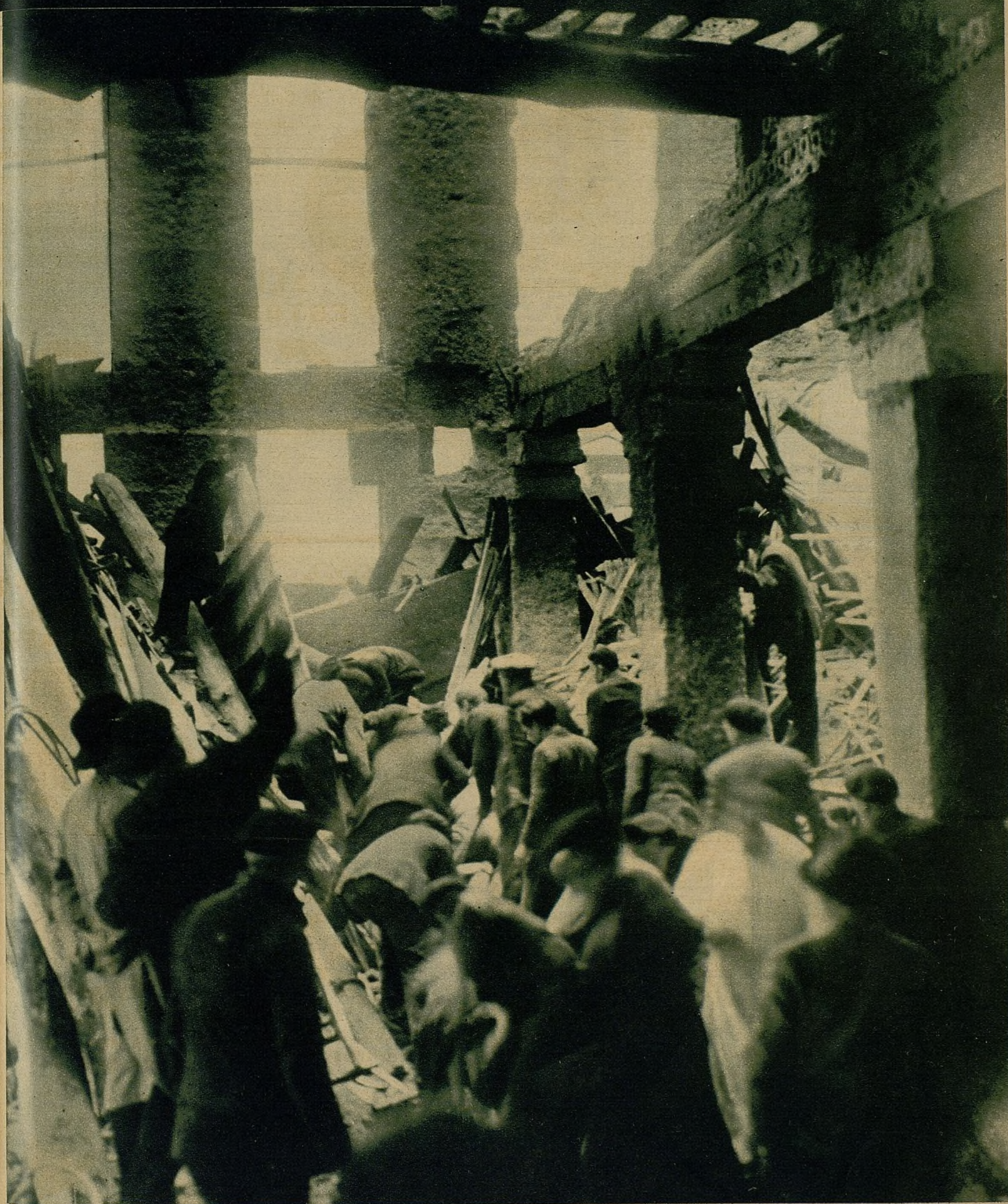
EN ORENSE MUEREN NUEVE OBREROS AL HUNDIRSE UNA CASA EN CONSTRUCCION, CUYAS OBRAS SE REALIZABAN SIN CONTROL TECNICO.—En una casa en construcción, en Orense, se desplomó parte del edificio cuando trabajaba en él una numerosa cuadrilla de obreros. Catorce de éstos quedaron sepultados, y de ellos sólo cinco fueron extraídos con vida, aunque con lesiones gravísimas. Se ha comprobado que las obras se realizaban sin dirección técnica, y que las imperfecciones de los cálculos y la mala calidad de los materiales originaron la catástrofe. El propietario y el contratista han sido encarcelados. En la foto, un instante de los trabajos de salvamento entre las ruinas
