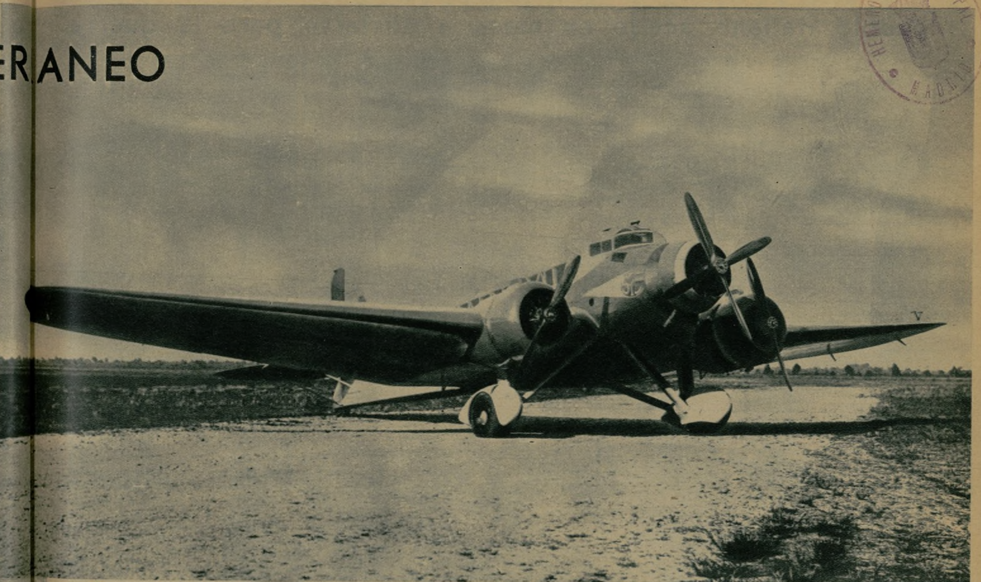
El trimotor "Savoia-73", de pasajeros, transformable en avión de bombardeo
