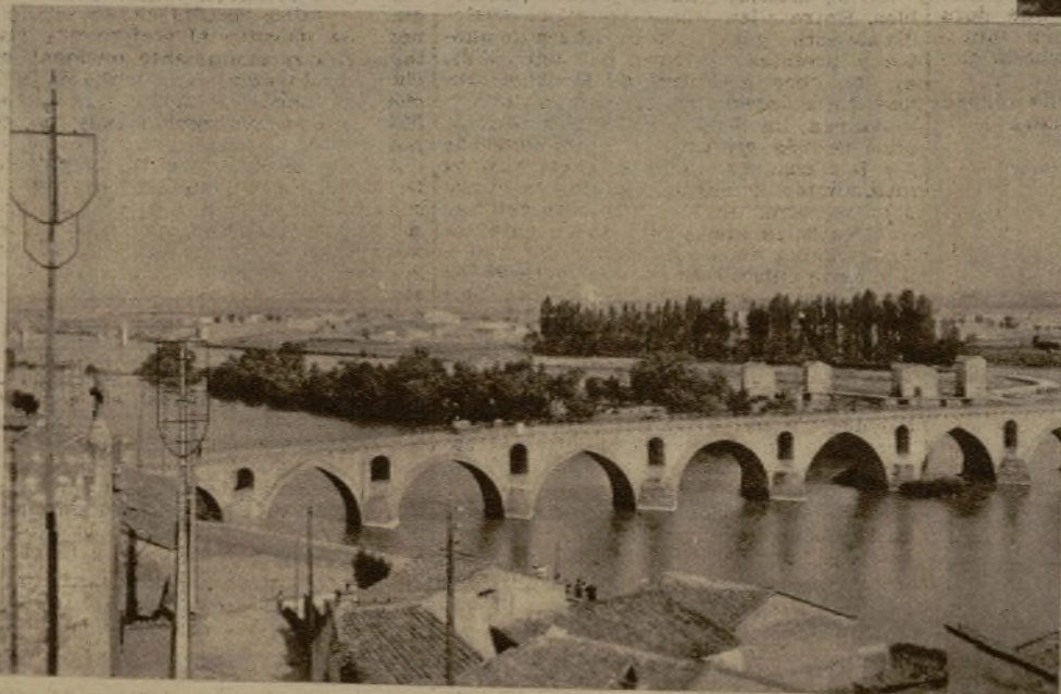
Puente de piedra sobre el río Duero, en Zamora, que se llamaba "nuevo" en el siglo XII. Su bellísima fábrica, que ha sido varias veces reconstruida, consta de dieciséis arcos ojivales...
