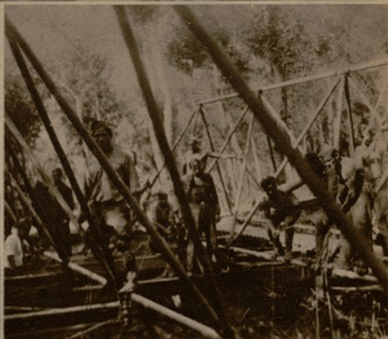
Los soldados del cuarto batallón de Zapadores Minadores durante el desmontaje de un puente de vigas inglés, construido en las maniobras celebradas en Prat del Llobregat
