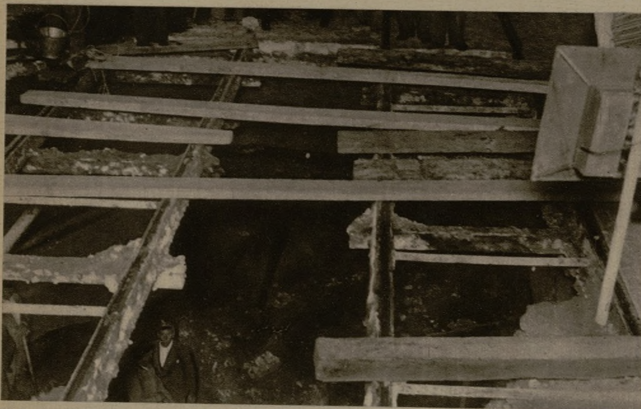
Obreros trabajando en el fondo del barranco formado en la plaza de España, esquina a la calle de Blasco Ibáñez. Se supone que el hundimiento se produjo por el reblandecimiento del terreno, causado por el agua de una cañería rota
