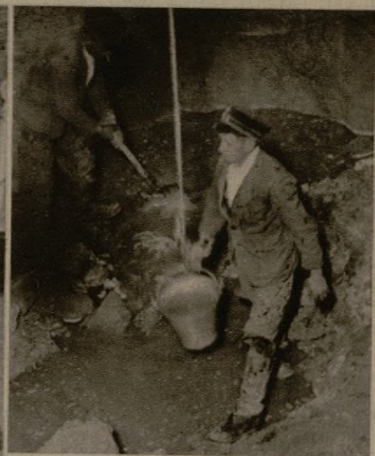
Obreros trabajando en el fondo del barranco formado en la plaza de España, esquina a la calle de Blasco Ibáñez. Se supone que el hundimiento se produjo por el reblandecimiento del terreno, causado por el agua de una cañería rota
