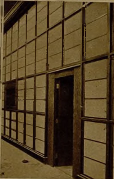
Las paredes de las cabinas emisoras de la Casa de la Radio, de Berlín, están provistas de un revestimiento especial para mejorar la acústica y para evitar los efectos del eco
