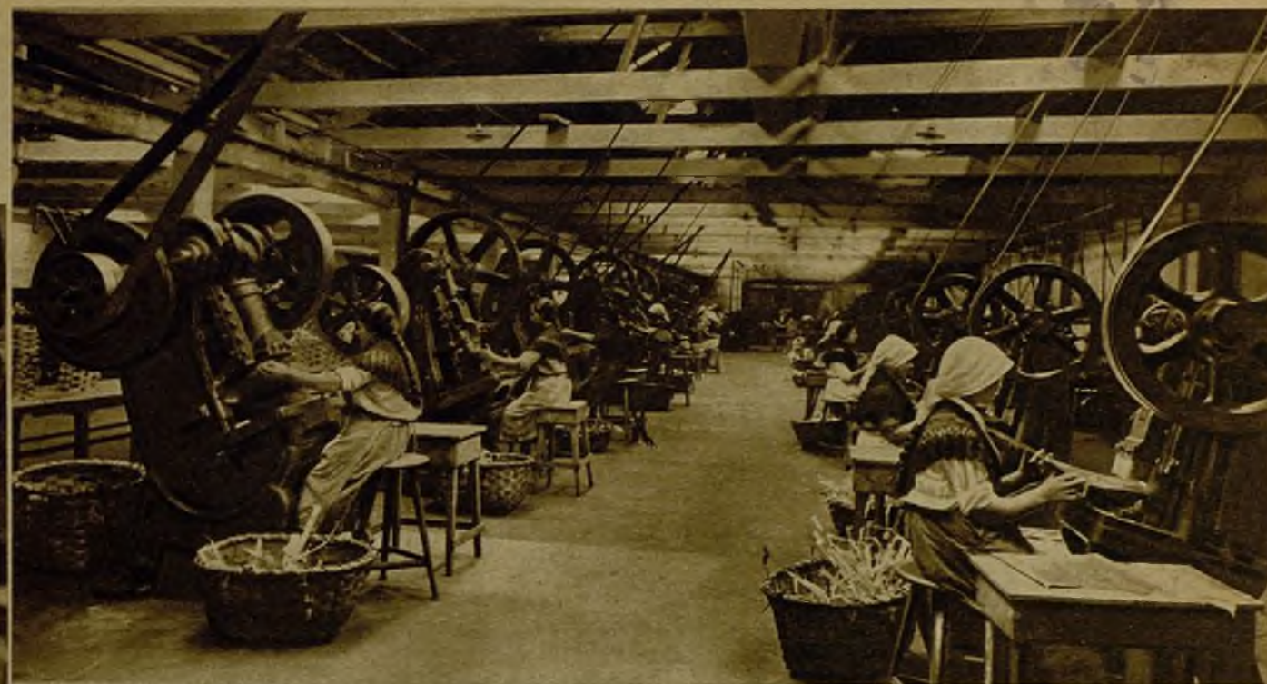
Fabricación de envases para la sardina en conserva en una de las fábricas que tanto abundan en el litoral del noroeste de España
