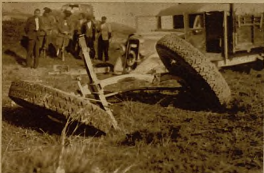
El juego de ruedas delanteras, desprendido totalmente al caer el coche por el terraplén
