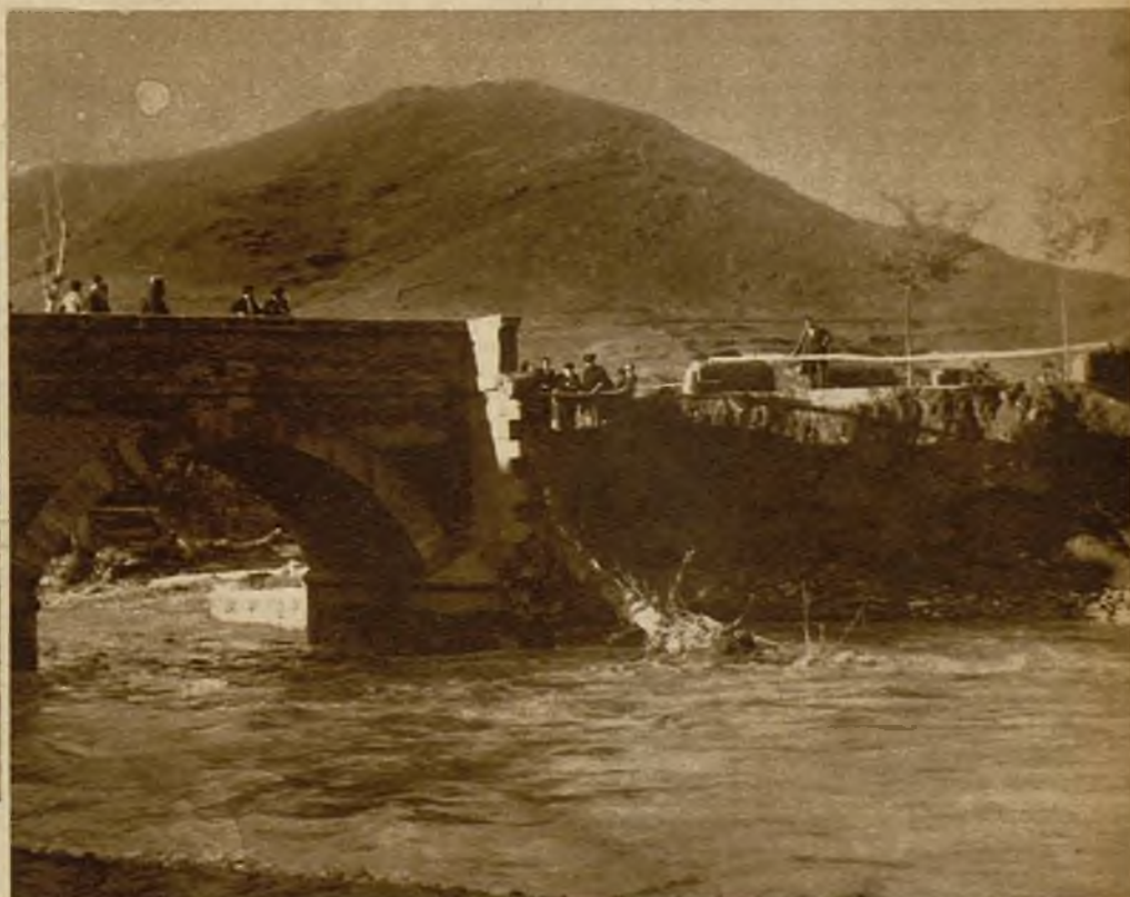
Otro puente destrozado en gran parte por la fuerza de la inundación en las inmediaciones de Brea de Jalón (Fotos Barrera)
