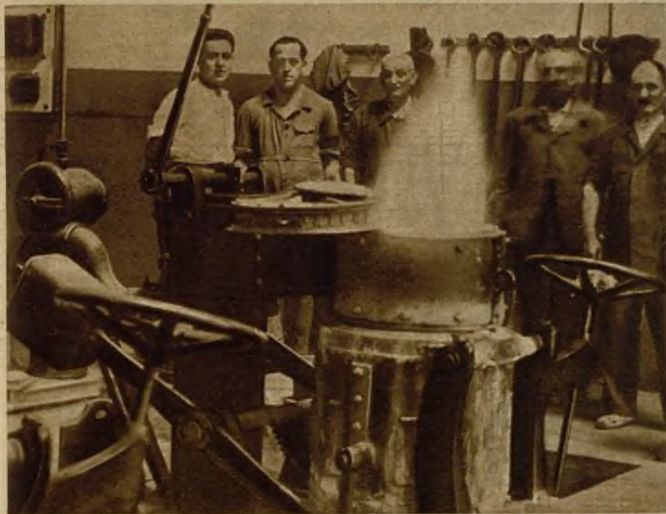
Horno de fundición donde las pesetas desgastadas se cuocen, liquidan y purifican
