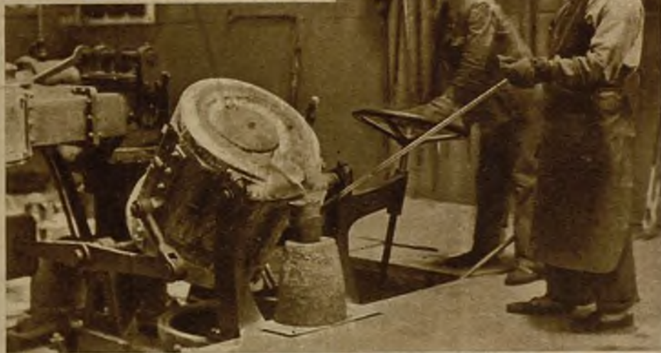
Del horno se vierte sobre el cazo la plata líquida después de la fundición (Fotos Marina)
