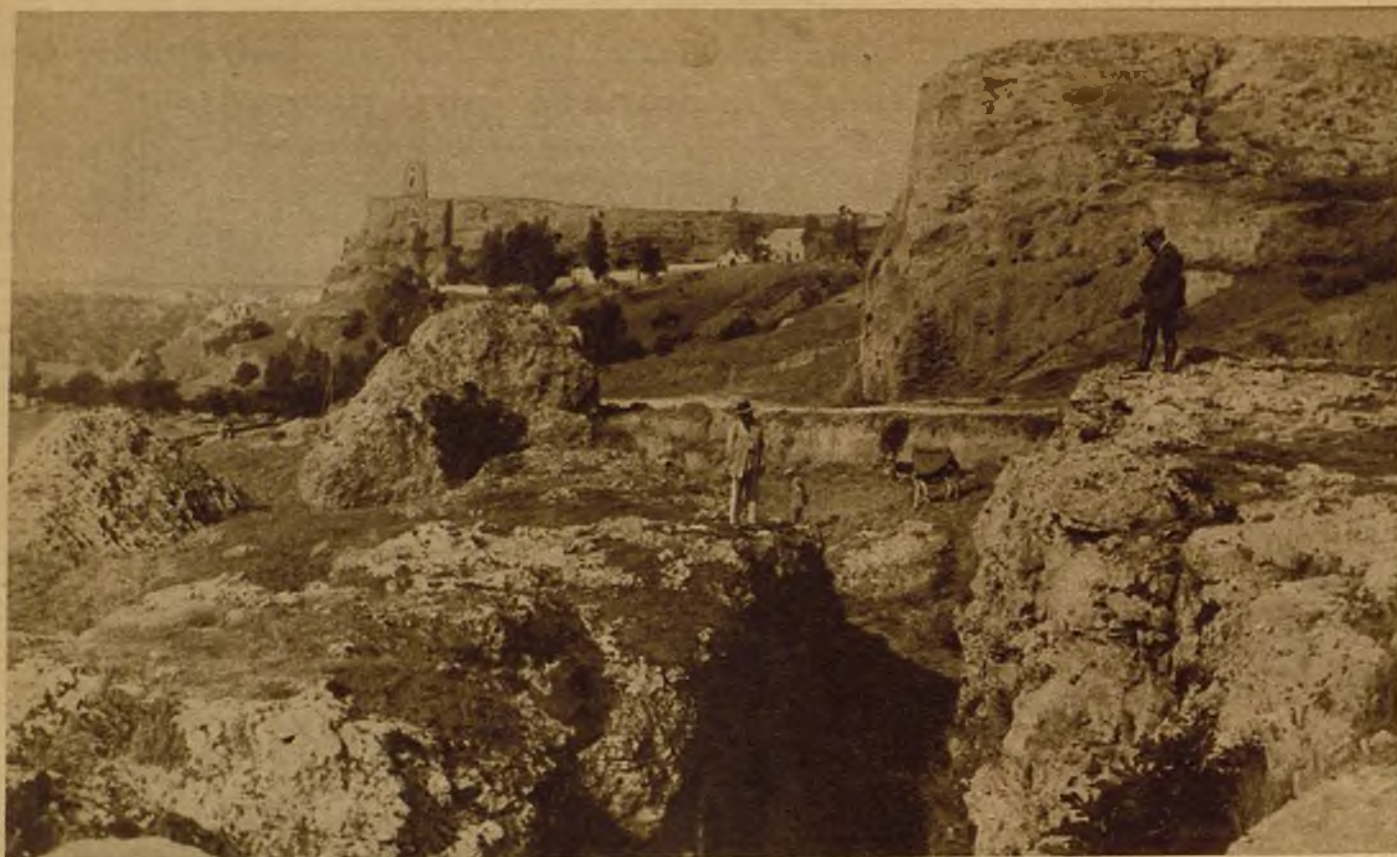
Grieta en el terreno, con desplazamiento vertical, en los alrededores de Carmona (Sevilla), producida a consecuencia de un terremoto
