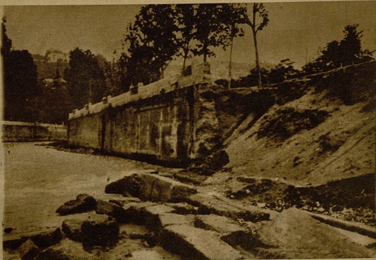
A consecuencia de las persistentes lluvias se produjo un corrimiento de tierras a orillas del Genil, en Granada, que originó el derrumbamiento de un trozo del muro de contención de las aguas. He aquí una vista del lugar del hundimiento
