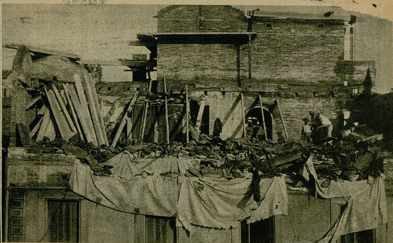
Aspecto de la parte alta de la casa en construcción donde ocurrió el derrumbamiento. Los albañiles trabajan en las reparaciones proyectadas (Fotos Gonsanhi)
