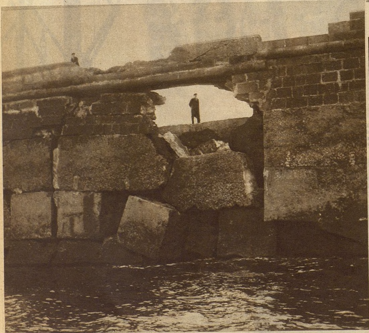
He aquí una elocuente muestra del estado de ruina en que se halla el rompeolas de Castro Urdiales, cuya reparación es de absoluta urgencia (Fotos Ramito y Freja)
